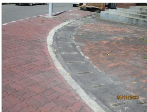
รูปที่ 2-10 รางระบายน้ำเพื่อรวบรวมน้ำส่งไปยัง ระบบบำบัดน้ำเสียส่วนกลาง
